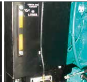
Automatic fuel refilling kit Kit de remplissage automatique
