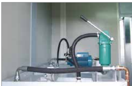
▲ Automatic fuel refilling kit mounted on oversized fuel tank Kit de remplissage automatique monté sur réservoir surdimensionné
