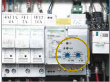
▲ Earth leakage protection Protection différentielle
